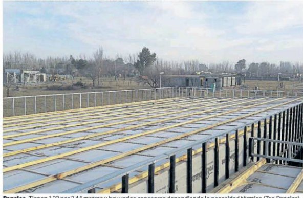
Paneles. Tienen 1,22 por 2,44 metros y hay varios espesores dependiendo de la necesidad térmica (Tao Paneles).
