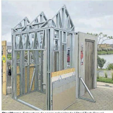
Steel frame. Estructura de acero galvanizado (Steel Tech Group).
